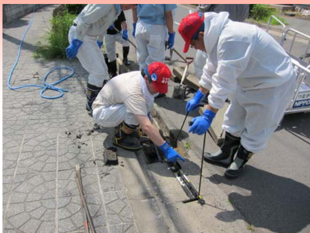
側溝のフタが固着しているためジャッキで持ち上げることも / 14 陣前半の参加者
